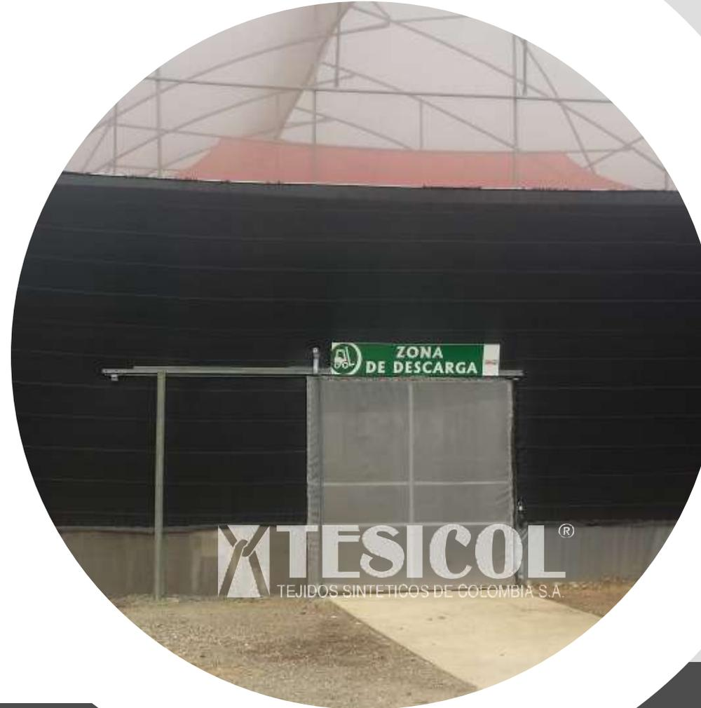
Cuando la construcción requiere el uso de aligerantes de placa e impedir el paso de agua, la utilización de telas laminadas es ideal, además son necesarias cuando el usuario requiere eliminar el paso del viento.
